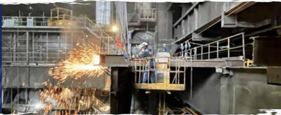
Die Schwierigkeit bei diesen Arbeiten bestand darin, dass der Hochofen an vier Seiten zwischen noch in Betrieb befindlichen Anlagen eingezwängt war. Außerdem befand sich der Hochofen in einem Gebäude, was bedeutete, dass alle auszubauenden Teile über in Betrieb befindlichen Anlagen entfernt werden mussten. Ein weiterer wichtiger Teil der Arbeit: Registrierung und Sanierung aller Asbestfunde vor dem Abbau.
