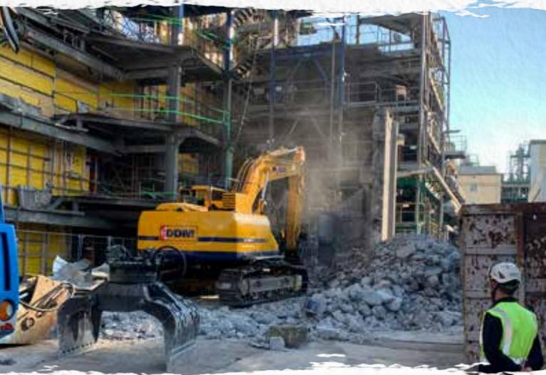
Die beiden Öfen wurden von oben nach unten abgebaut. Die Wände der Öfen wurden von unseren Demontagespezialisten in Stücke geschnitten. In diese Stücke wurden Löcher geschnitten, durch die Ketten geführt werden konnten. Das Herunterheben der schweren Teile erfolgte mit geeigneten Hubvorrichtungen; schwere und präzise Hebevorgänge, bei denen man ständig wachsam sein muss.
