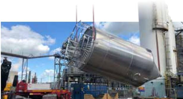
Für das Abheben der Fassade oberhalb 20 Meter wurde beschlossen, eine Ausgleichsvorrichtung anfertigen zu lassen, mit der die Fassadenverkleidung samt Isolierung und Konstruktion kontrolliert abgehoben werden konnte. Der Vorteil dieser Methode ist, dass sie sicherer und schneller ist und die Umgebung weniger kontaminiert. Das Isoliermaterial konnte unten kontrolliert aus den Wänden entfernt werden.
