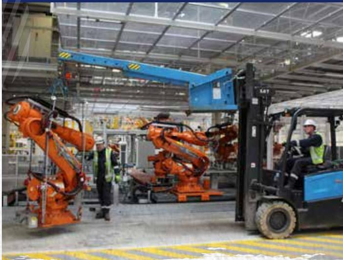
Dieses Projekt umfasste mehrere wichtige Aktivitäten, darunter die Demontage und den Abtransport von 750 Robotern, einschließlich der dazugehörigen Steuerschränke, die zur Wiederverwendung bestimmt waren. Daneben wurde die Karosseriebauanlage auf einer Fläche von 69.646 m<sup>2</sup> entfernt und insgesamt 7.000 Tonnen sonstiger Anlagen demontiert.
