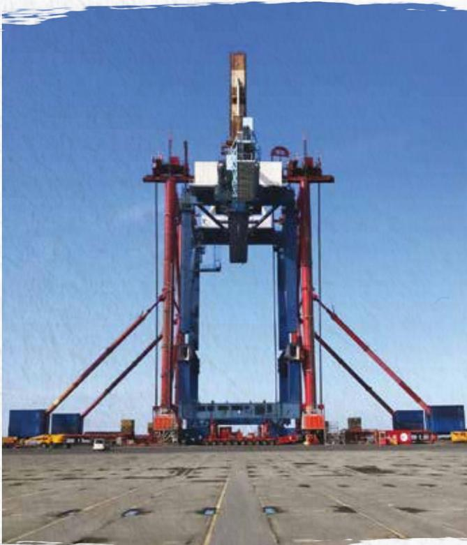
Das Projekt war für DDM eine Herausforderung, da eine neue Abbaumethode eingeführt wurde. Mithilfe eines Portalsystems mit Hubsystem wurden die Krane an vier Punkten aufgenommen, wodurch die Grundkonstruktion unter dem Kran entfernt werden konnte. Die demontierten Krane wurden dann auf SPMTs (Transporter für schwere Bauteile) gestellt und abtransportiert.
